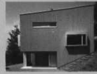
Mit dem Hang verzahnt Mischbau in Winterthur Beat Rothen Architekt, Winterthur
