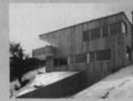
Inszenierung am Hang Holztafelbau in Gelterkinden Erny & Schneider Architekten, Basel
