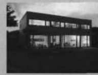
Leise Referenz an die Moderne Holzelementbau in Burgdorf Aeschlimann und Willen, Burgdorf
