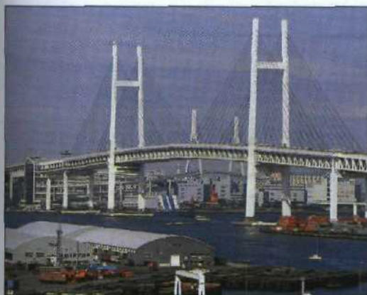
Die weitgespannte Yokohama Bay Bridge, Zentral-Honshu
