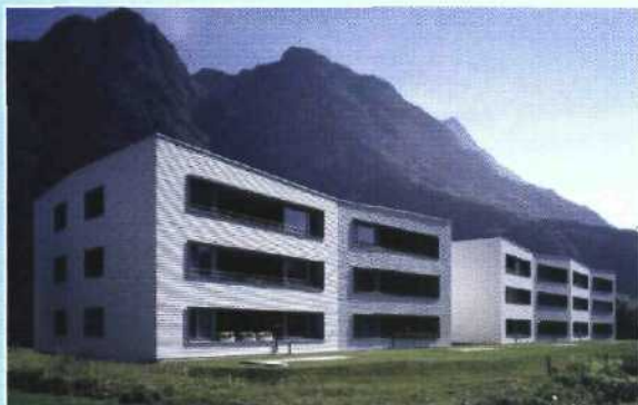
Wohnüberbauung, Balzers Architektur und Planung: Arbeitsgemeinschaft Adrian Christen, Ivan Cavegn
