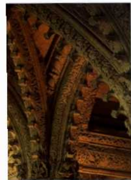
Sewölbe der Rosslyn Chapel in den 'entland Hills (siehe S. 87)
