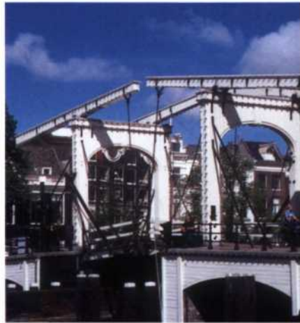
Aus Holz erbaut und rekonstruiert: die Magere Brug
