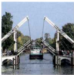
Klappbrücke an der Amstel
